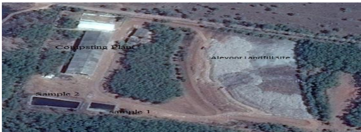
Fig.1 Alevoor landfill site
